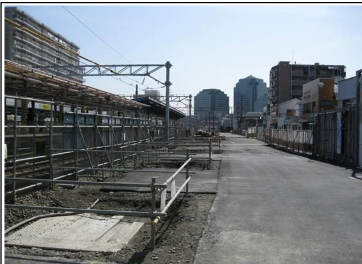
写真-① 基礎杭10本施工後の1番線南側 （2、3番線間においても15本施工）
