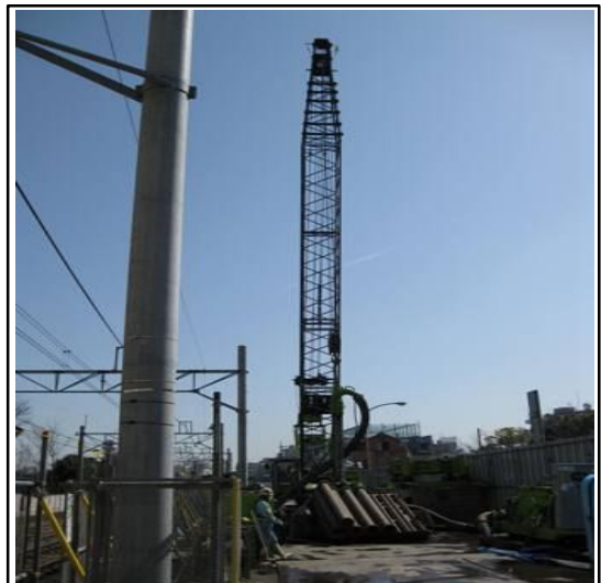
写真-② 天王町1号～2号踏切間南側の 杭施工風景（3月末までに17本施工予定）
