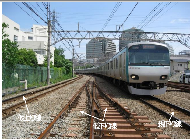
写真④ 天王町2号～3号踏切間軌道敷設状況 (天王町3号踏切付近より横浜方面を望む)
