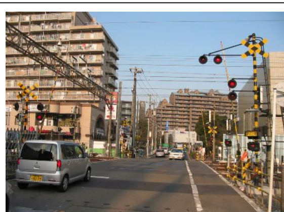
遮断機力を軽減された天王町3号踏切 (平成19年2月撮影)
