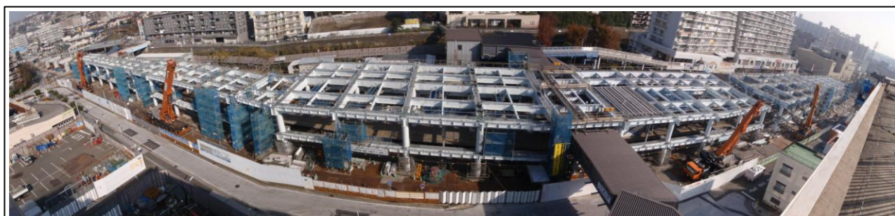
写真-③ 星川駅鉄骨架設、3階乗降ホーム階スラブ架設状況 （南側から北側を望む）
