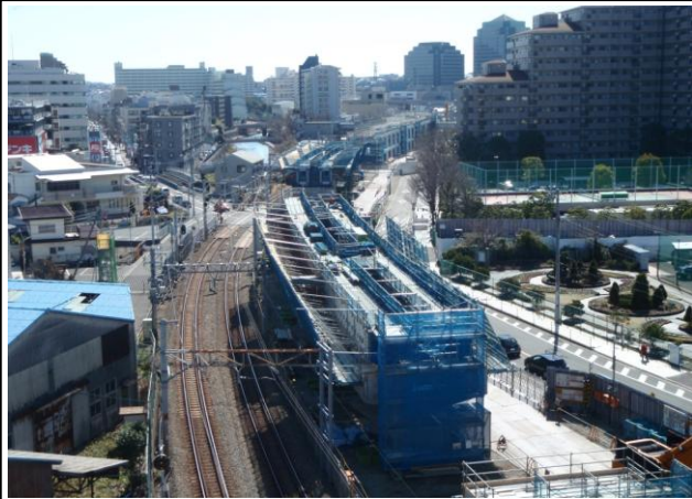
写真-② 星川第2架道橋架設状況(現況) (海老名方から横浜方を望む)
