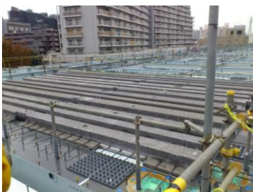
架設状況写真
