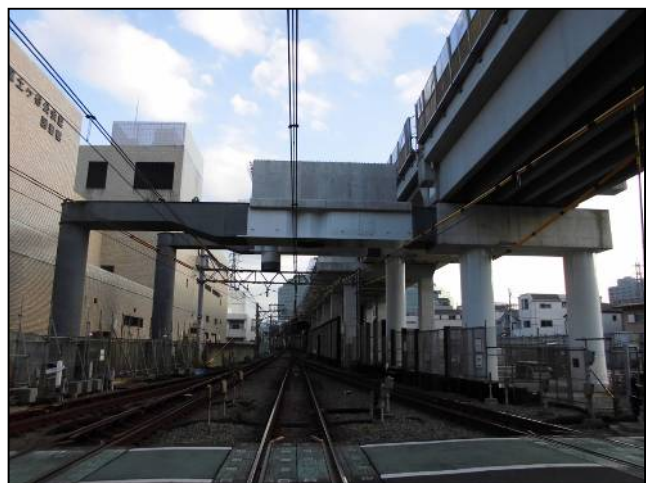
写真④ 天王町3号踏切付近
