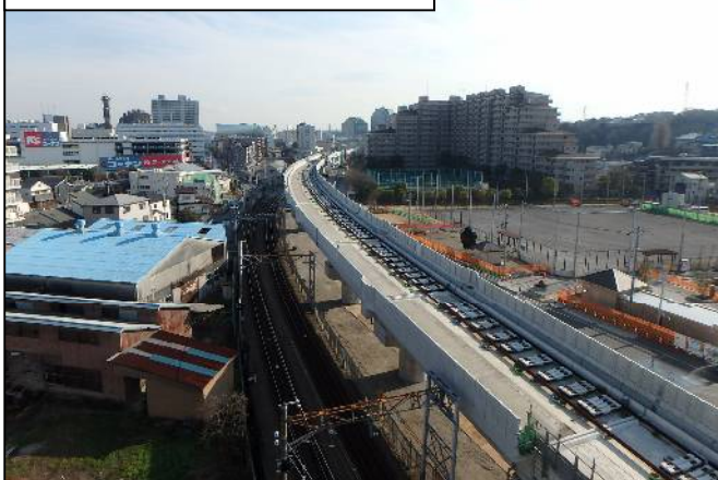
写真⑤ 星川3号踏切付近
