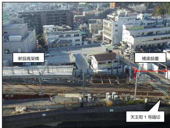
写真② 天王町1号踏切付近
