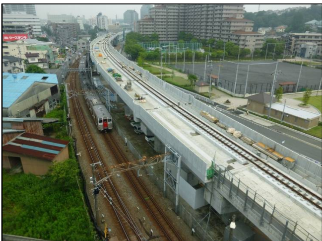
写真③ 下り線のレール敷設状況
