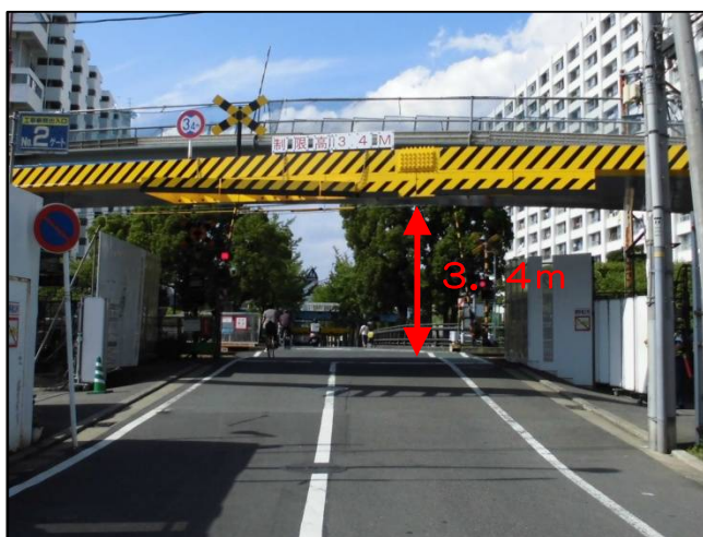
写真② 桁下の高さ制限 3.4m
