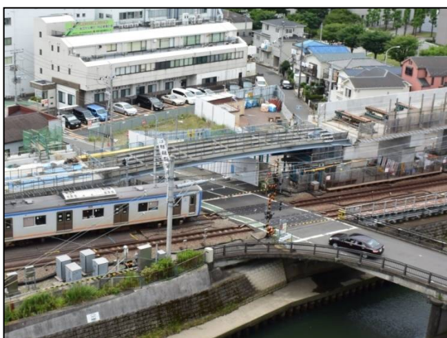
写真① 天王町1号架道橋の設置状況
