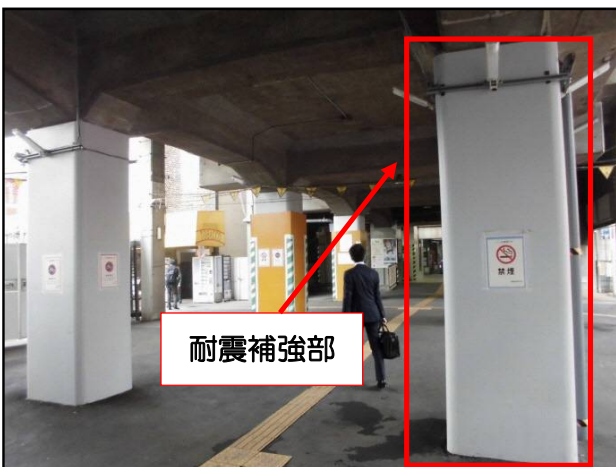
写真 3. 耐震補強した柱
