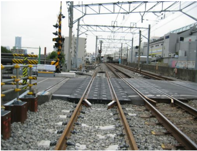
写真一① 天王町1号踏切付近の起点方切替え箇所 (平成19年10月撮影)
