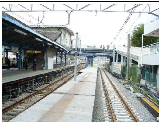
写真一④ 施工中の星川駅仮設上りホーム (平成19年10月撮影)
