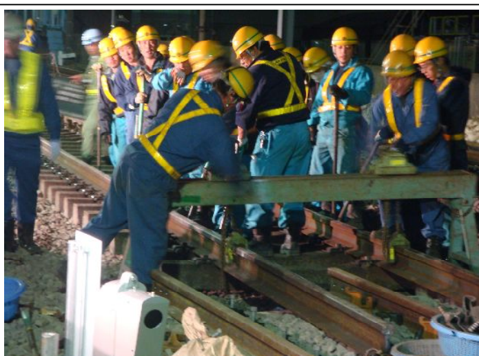
写真① 人力での軌道接続作業：天王町1号踏切付近 （平成19年11月撮影）
