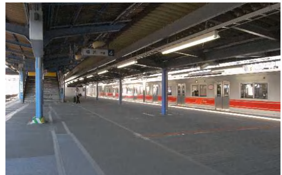
写真一② 現在の星川駅上りホーム
