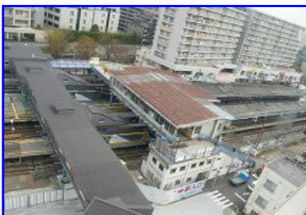
写真一① 解体前の星川旧駅舎 (平成20年4月 撮影)
