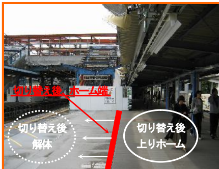
写真一③ 今後の上りホーム (平成20年5月 撮影)
