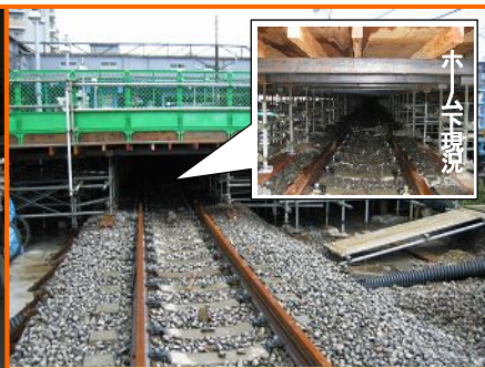
写真一④ 上りホーム下現況 (平成20年5月 撮影)
