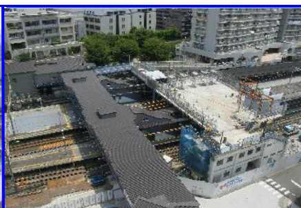
写真一② 解体中の星川旧駅舎 (平成20年6月 撮影)
