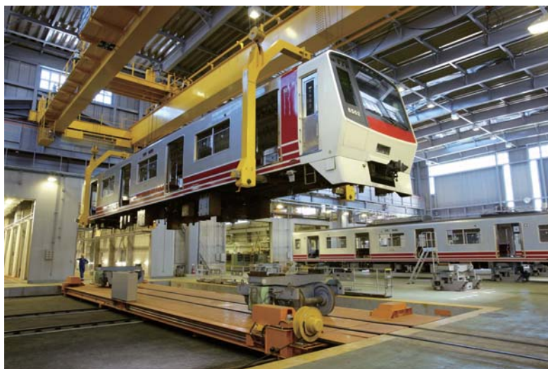
オーバーヘッドクレーン
