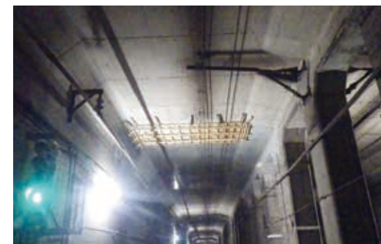
トンネル内の改修
