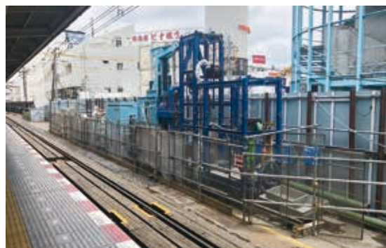
基礎杭打設工事
