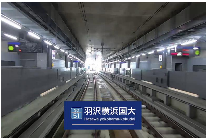
運転台からの風景(羽沢横浜国大駅)
