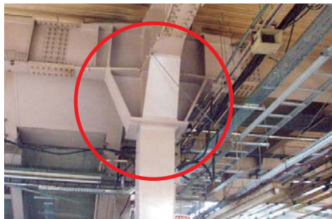
駅の耐震補強
