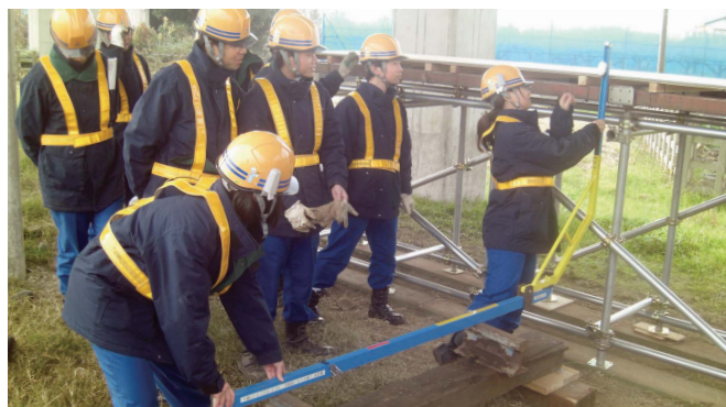
応急復旧訓練でホーム定規を使用し 仮設ホームの高さとレールからの離れ具合を確認している様子
