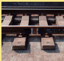
↑コンクリートで固定された線路
