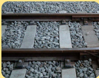
↑コンクリートで固定された線路
