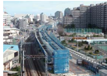
道路交差点橋桁の施工状況
