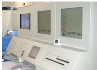
架線検測装置
