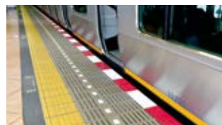
二俣川駅に設置したCPライン
