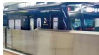
横浜駅に設置したホームドア
