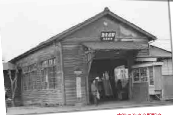
木造の海老名駅駅舎
