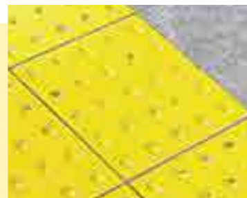
▲警告ブロック(点状ブロック)
