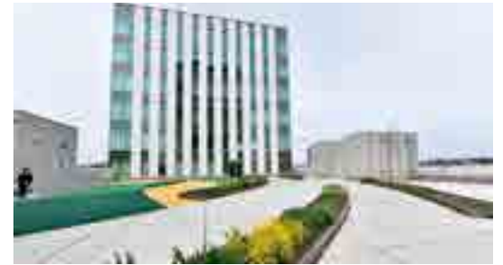
↑グリーングリーンテラスの様子。
