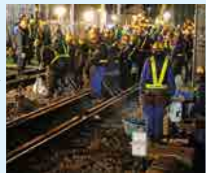
↑仮線への切り替え工事では、数百人の作業員が夜を徹して人力で線路を移動させました。
