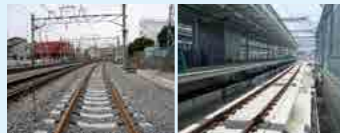
↑バラスト軌道の線路。 ↑直結軌道の線路。
