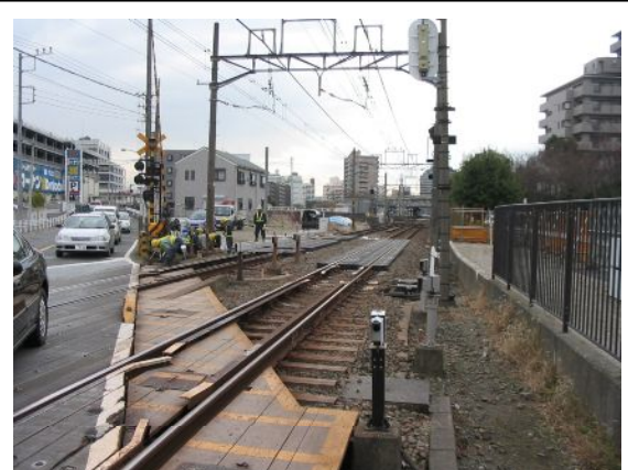
移設工事中の星川2号踏切付近（平成19年1月撮影）
