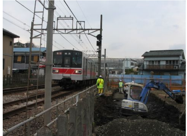
星川4号踏切付近で進めている仮線路盤整正工事 （平成18年12月撮影）
