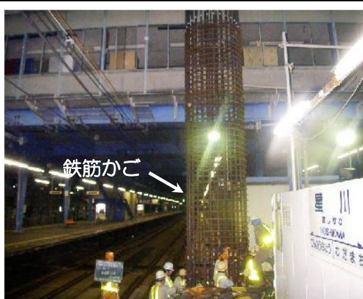
写真-⑤ 鉄筋かご挿入状況
