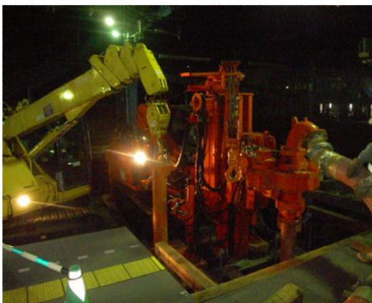
写真-④ 地盤掘削状況
