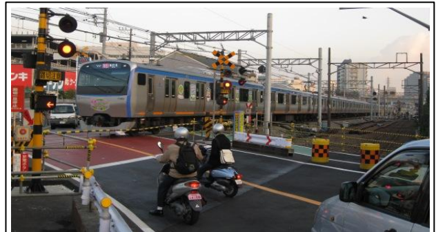
写真-⑥ 星川2号踏切の現況（南側から横兵方を望む）
