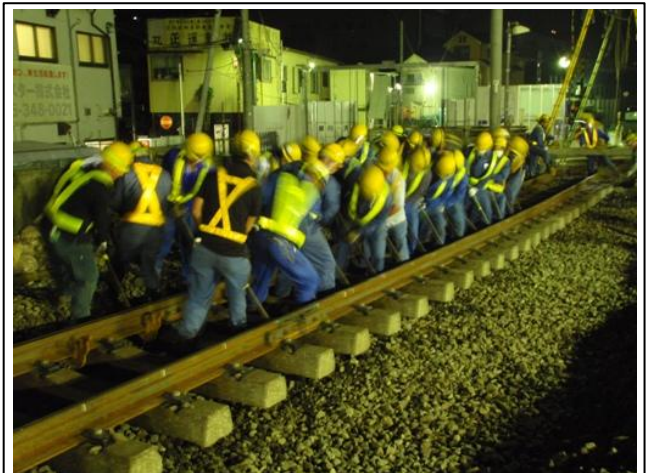
写真-① 人力による軌道振込み作業（天王町1号踏切横兵方）
