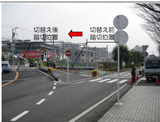
写真-⑤ 切替え後（南側から北側を望む）
