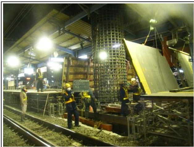
写真-①星川駅下りホーム下鉄筋かご建込み状況
