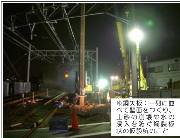
写真-② 鋼矢板打設状況（天王町1号踏切横浜方）
