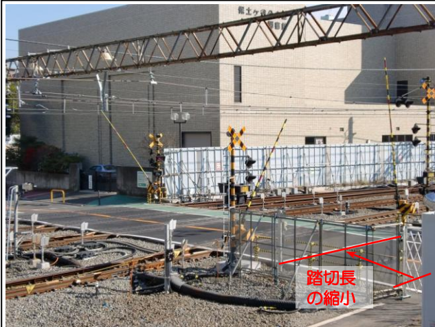
写真-③ 天王町3号踏切の踏切長縮小状況 (南側から北側を望む) (踏切長を24.3m→14.3mに縮小)
