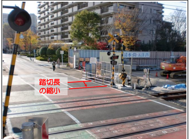
写真-④ 星川1号踏切の踏切長縮小状況 (北側から南側を望む) (踏切長を14.4m→9.2mに縮小)
