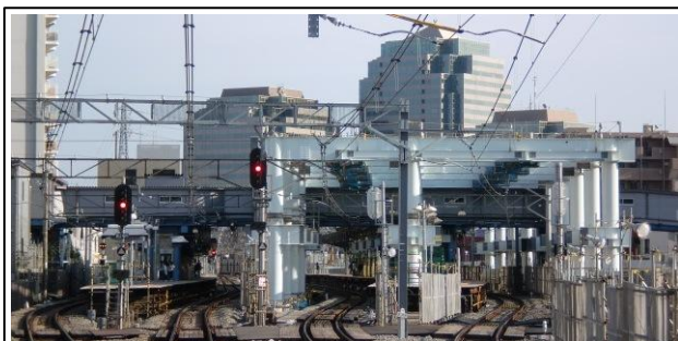
写真-① 星川駅鉄骨架設状況 (海老名方から横浜方を望む)
