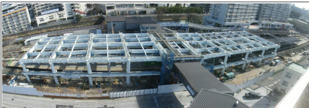
写真-② 星川駅鉄骨架設状況 (全体) (南側から北側を望む)
