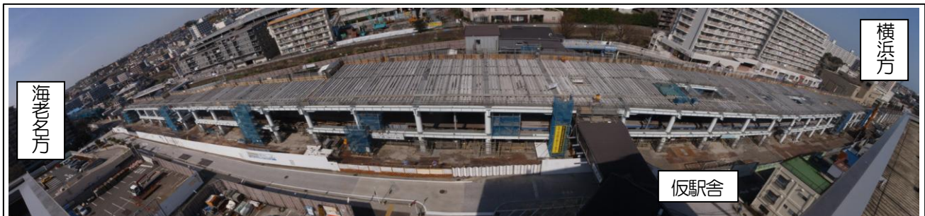
写真-① 星川駅鉄骨架設、3階乗降ホーム階スラブ架設状況（全景） （南側から北側を望む）
