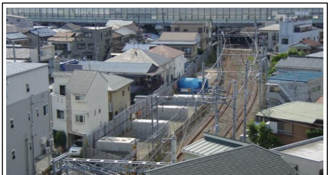
写真-③ 星川4号踏切～終点方高架橋施工状況 （横浜方から海老名方を望む）
