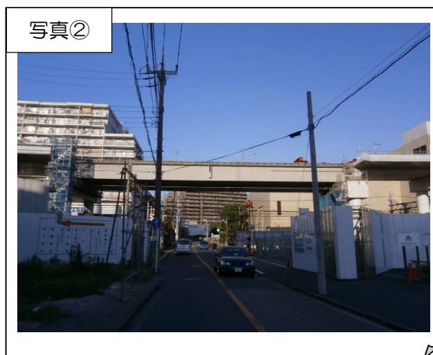
天王町第 3 架道橋桁架設完了 (南側から北側を望む)
