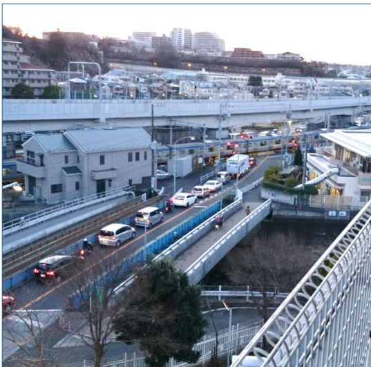
星川2号踏切 高架化前
