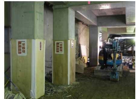
写真3. 天王町駅舎躯体構築
