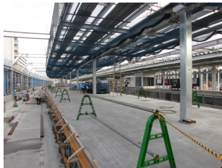
写真2. 星川駅上りホーム構築
