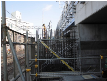
写真1. 上り線用躯体構築
