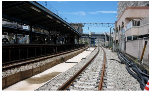
星川駅部の仮上り線(仮4番線)軌道 (平成19年6月撮影)
