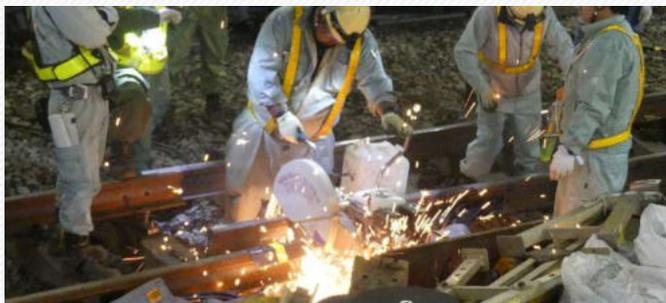
切替のため線路を切断しています
