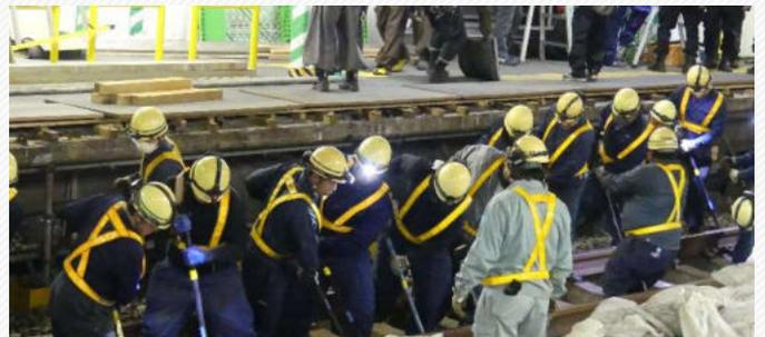
切断した線路を新しい線路へ動かします
