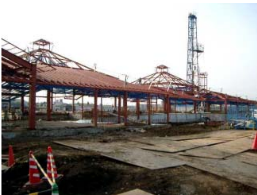
建設工が進むスーパー銭湯「ゆめみ処こち湯」 後方に見えるのが天然温泉採掘用の温泉掘削リグ
