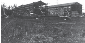
建設中の希望ヶ丘高校校舎
