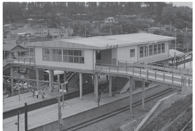
二俣川橋上駅舎
