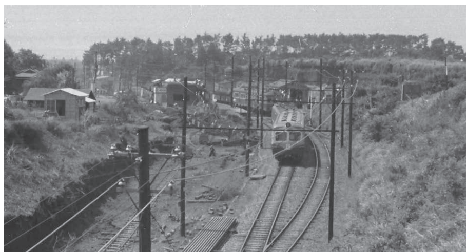
複線工事中の三ツ境駅付近
