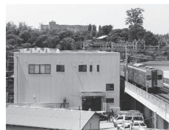
二俣川変電所
