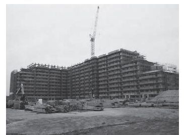
工事中のステージ星川
