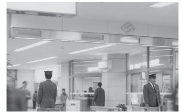
改札口上部の出入口表示機
