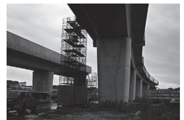
第3期区間建設工事(左の高架橋は一部区間で併走する横浜市営地下鉄)
