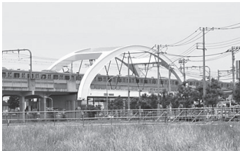
ニールセン橋
